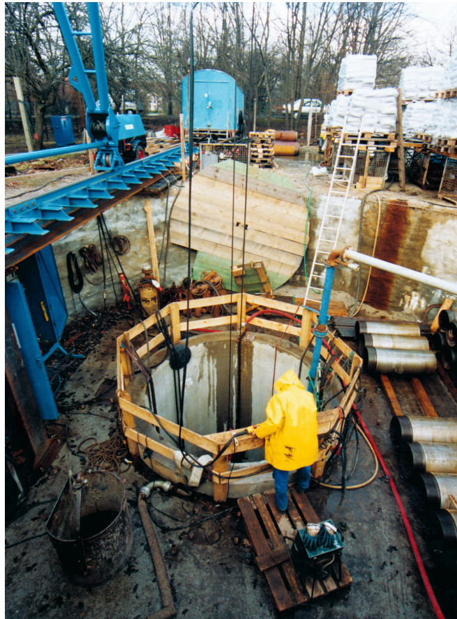
Abb. 22: Sanierung Grundwasseranstieg Hoyerswerda – Horizontalfilterbrunnen (SN-O)
