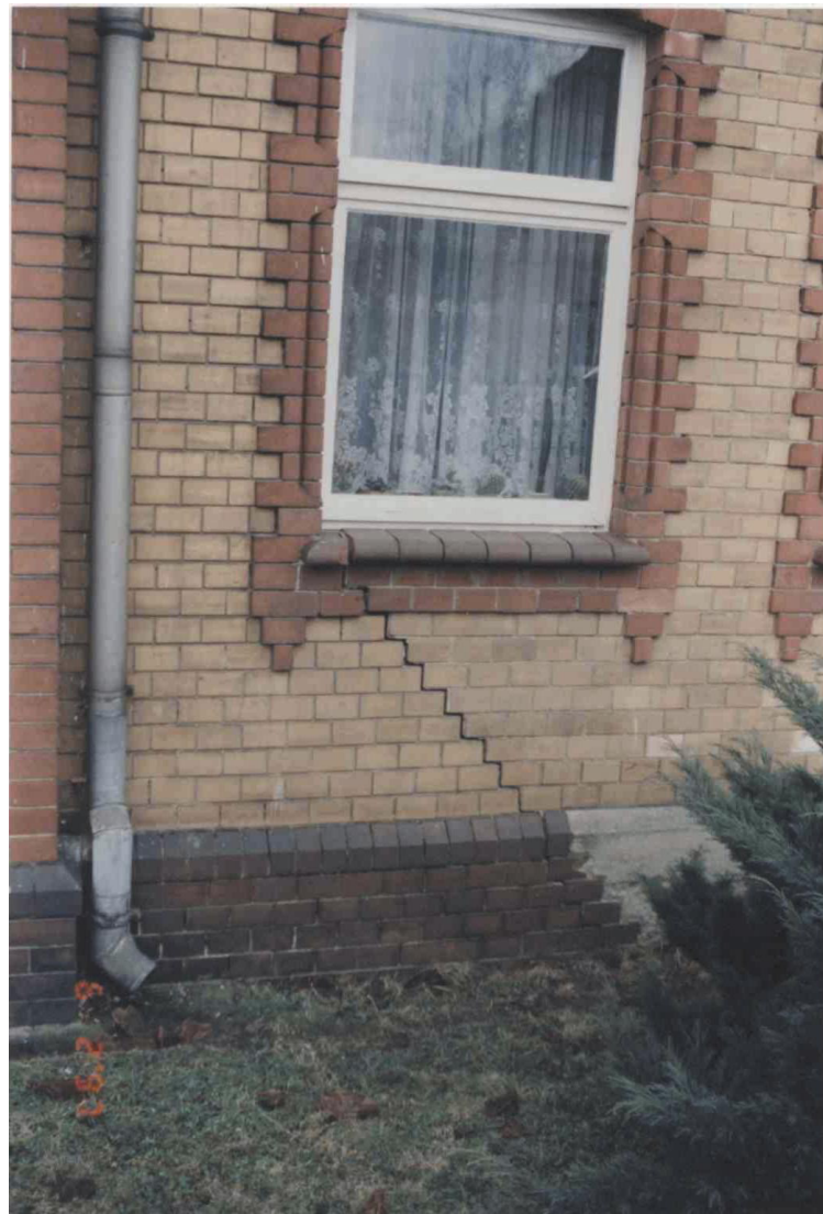
Abb. 20: Gebäude mit anerkanntem grundwasseranstiegsbedingtem Bergschaden in Delitzsch (SN-W)
