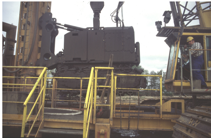
Abb. 6: Herstellung einer Dichtwand im Tagebaubereich Cottbus-Nord (BBG)
